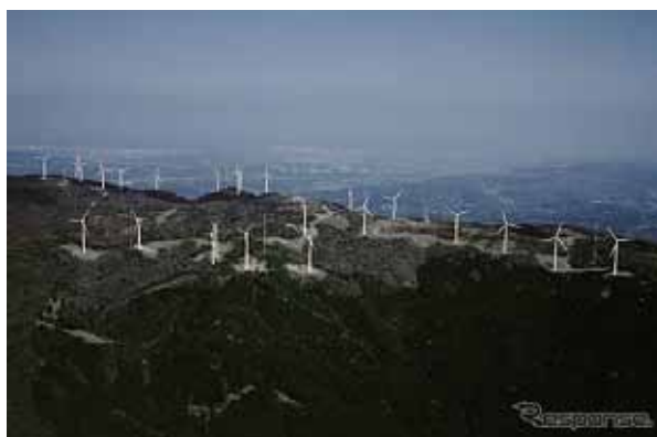
三重県の室生赤目青山国定公園の中心にある青山高原 では今後60基までの風力発電施設の増設予定がある。
